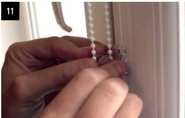
Průhlednou kladku pro řetízek (**číslo 7**) přilepíme nebo přivrtáme k rámu okna v požadovaném místě tak, aby byl řetízek napnutý a ovládání jednodušší. Dbejte na to, aby bylo toto bezpečnostní zařízení namontováno. V opačném případě by mohlo dětem hrozit uškrcení. Toto bezpečnostní zařízení musí být namontováno v maximální možné vzdálenosti od ovládacího mechanismu. Vždy používejte toto zařízení tak, aby šňůry nebo řetízky byly mimo dosah dětí.
