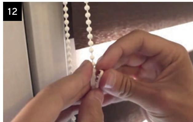
Vyzkoušíme funkčnost řetízku a délku rolety jejím spuštěním a vytažením. Roleta při spuštění nesmí narážet do kliky okna. Pokud chceme můžeme využít i brzdičky (**číslo 6**), ale není to nutné. Brzdička se zastaví o horní mechanismus rolety a zabrzdí tak roletu v místě, kde potřebujeme. Pokud dále potřebujete, ať roleta sjízdí níže, brzdu sundáme, vysuneme roletu do potřebné délky a zpět nasadíme brzdu na vrchní část řetízku. A je hotovo!
