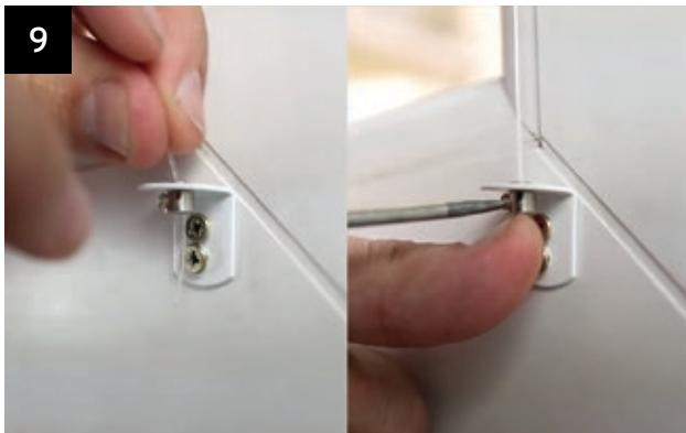
Otvorem v dílech (**číslo 3**) provlékneme vodicí silon. S pomocí malého plochého šroubováku utáhneme šroubek v otvoru tak, aby došlo k napnutí silonu.
